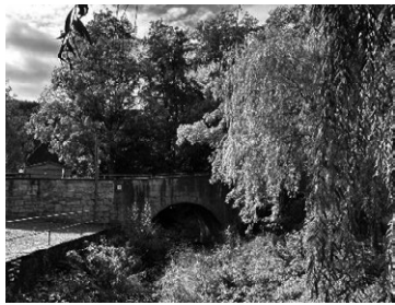
Alte Ilmbrücke von 1856 Foto: S. Günther
